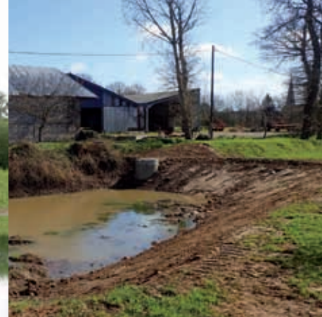
↑ Aménagement d'une surverse et d'un «débit de fuite» sur une mare privée à Manneville-ès-Plain
