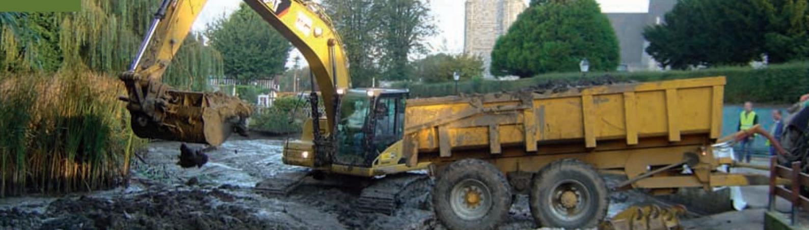
↑ Curage mécanique de la mare communale de Manneville-ès-Plain
