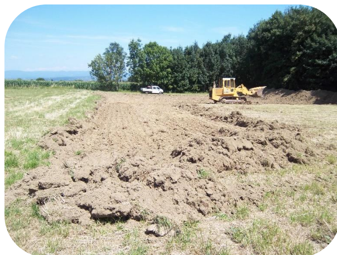
Travaux de décapage d'un ancien champ de maïs à STETTEN (68) _ Juillet 2011
