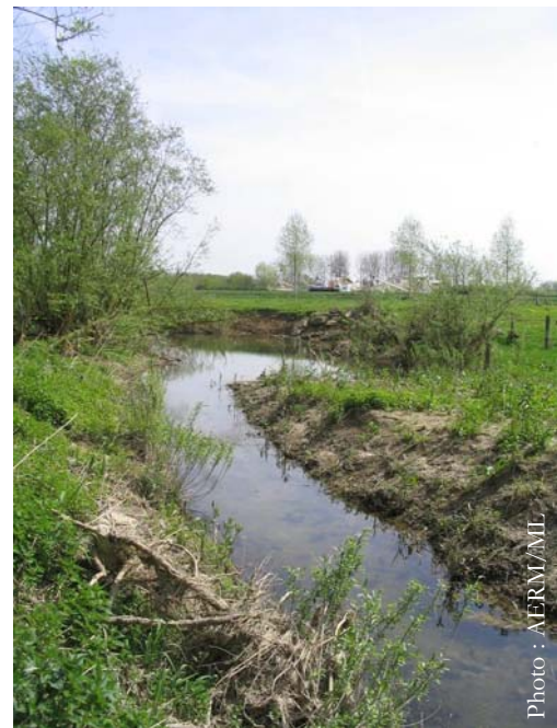
Chenal de communication recreusé entre deux poches d'eau préexistantes
