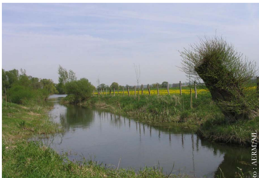
Noue après travaux : berge retalutée (à gauche), plantations et saule recépage (à droite)
